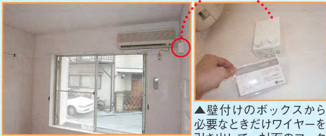
▲室内干し用のワイヤーを設置。
