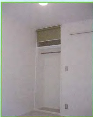
▲収納部の建具修繕の際にロールスクリーンを用いて、コストを抑える。
